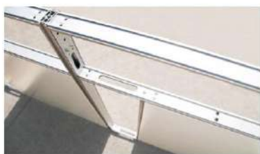
直向與橫向線槽的 組合結構
